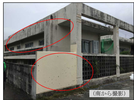
④住宅壁面の泥はね (赤丸は泥はね箇所)
