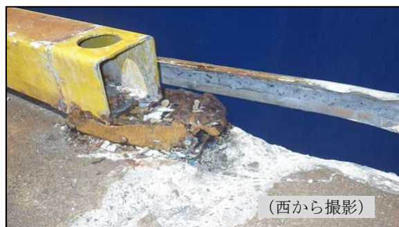
② 岸壁の損壊
