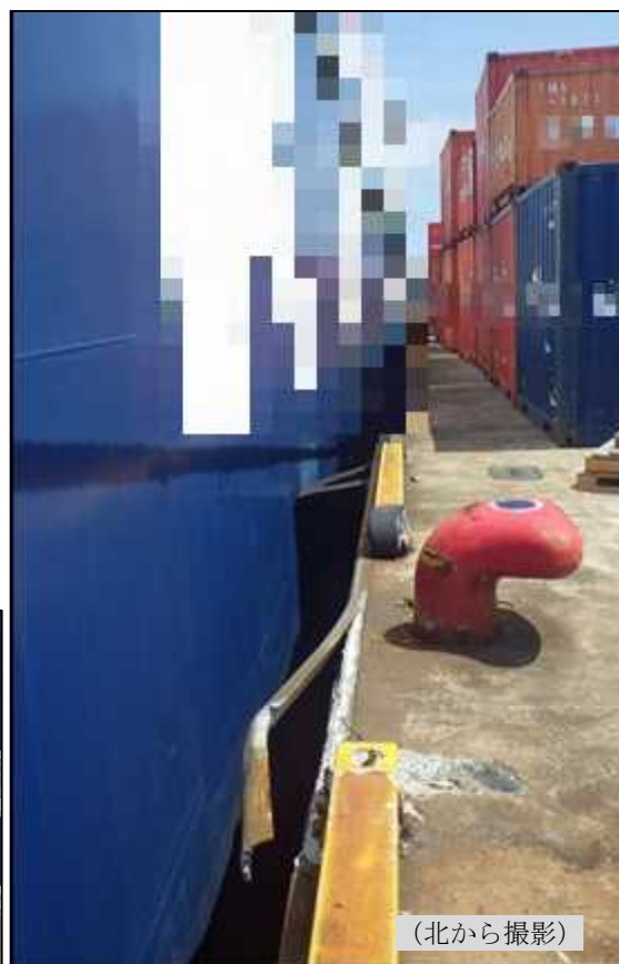
② 岸壁の損壊（一部画像を加工しています）
