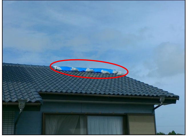
②屋根瓦がめくれた住家
