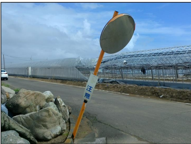
⑪傾倒したカーブミラー
