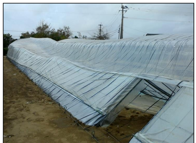
⑫変形したパイプハウス
