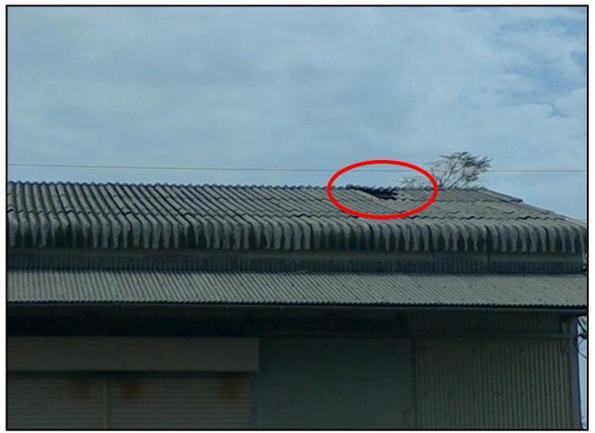
④屋根の一部が剥離した倉庫
