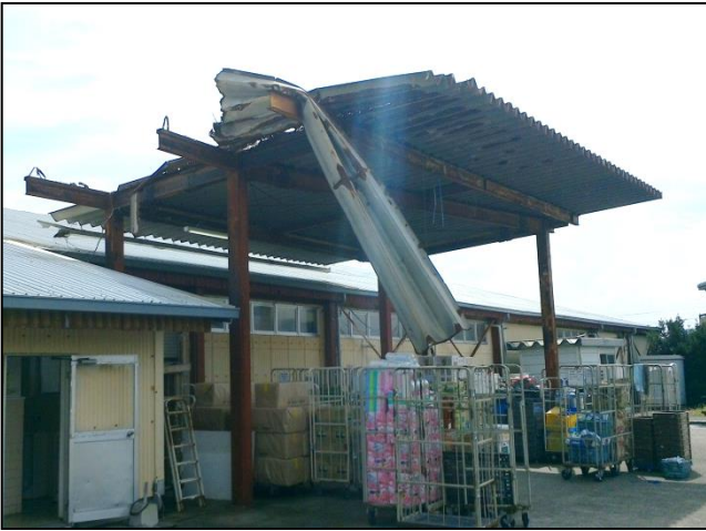
③屋根が破損した店舗
