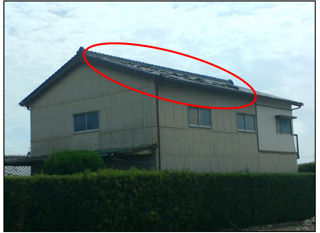
⑧屋根瓦がめくれた非住家
