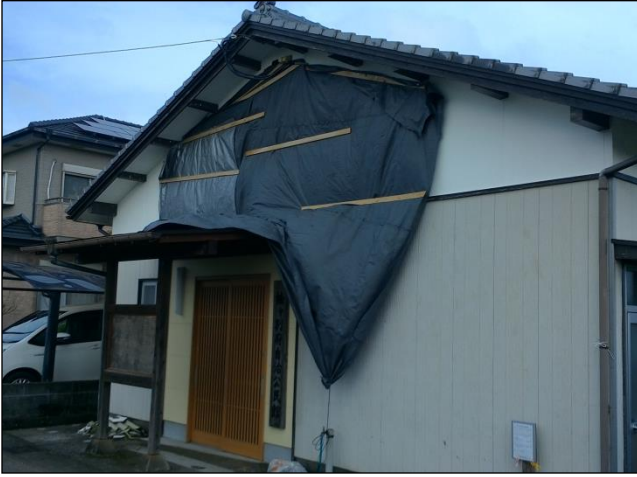
①側壁が破損した住家
