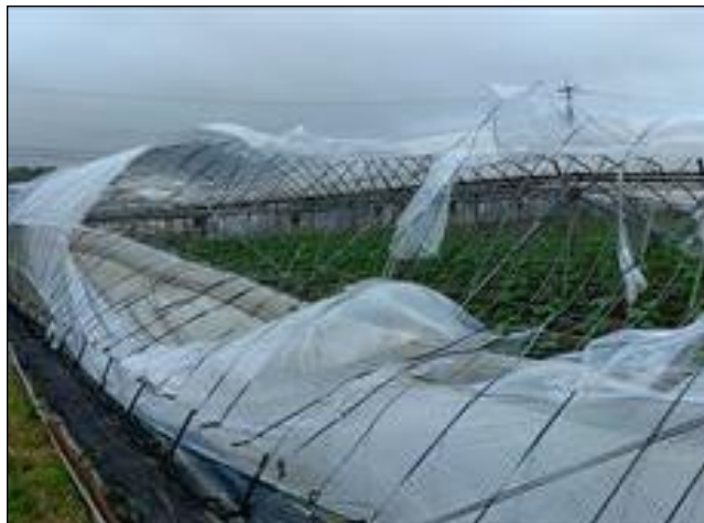
②変形したパイプハウス
