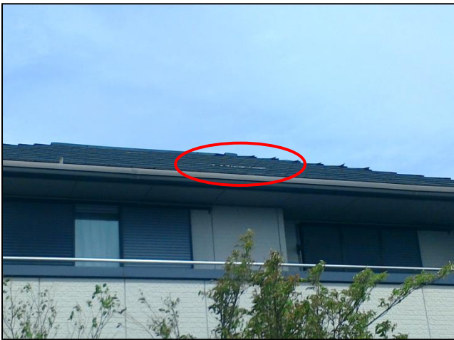
⑨スレート葺屋根が破損した住家
