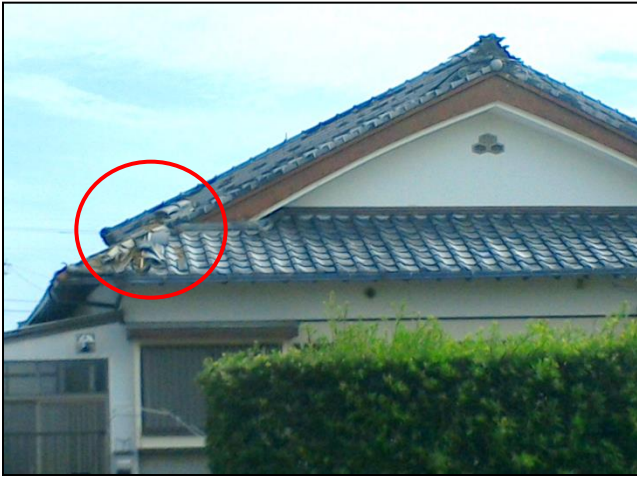
⑦屋根瓦がめくれた住家
