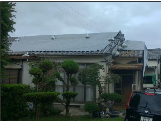
⑤屋根瓦がめくれた住家
