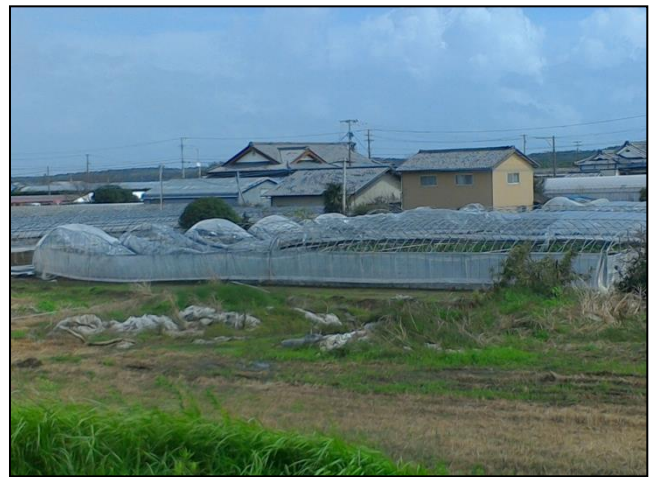
⑩変形したパイプハウス
