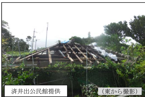
④瓦屋根の飛散
