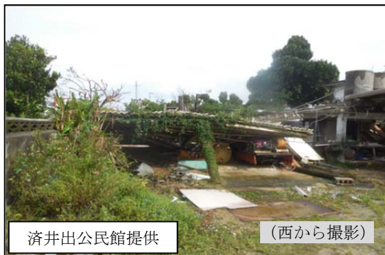
⑦納屋の屋根被害
