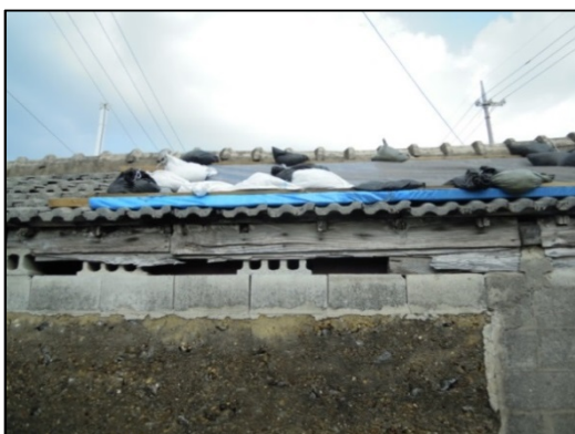
③屋根瓦飛散
