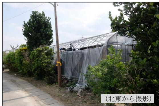
⑤ビニールハウスシーートの剥離
