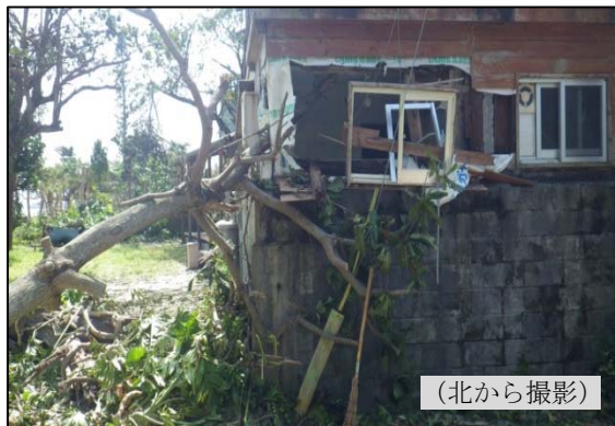
②住宅の一部損壊
