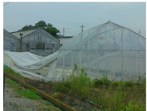
④変形したパイプハウス 【南方向から撮影】
