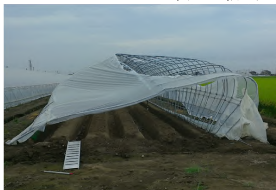
②変形したパイプハウス 【西方向から撮影】
