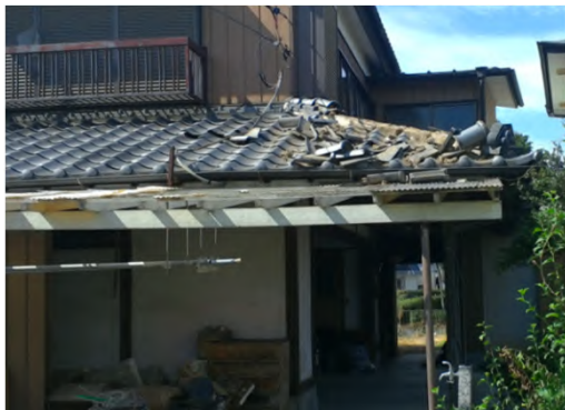
①瓦がめくれた住家 【南方向から撮影】
