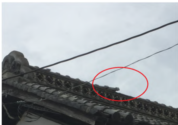
③瓦がめくれた倉 【南東方向から撮影】
