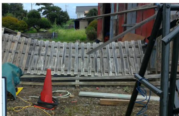
①根元から折れた木造の塀 【南方向から撮影】
