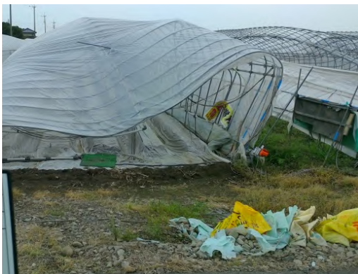
③変形したパイプハウス 【西方向から撮影】
