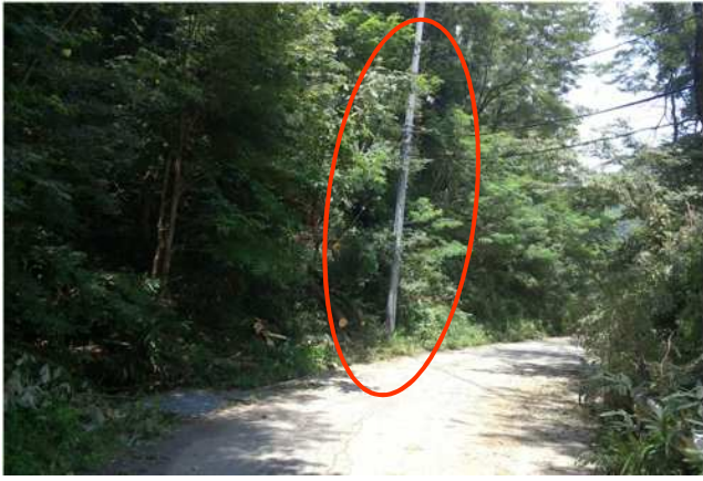
倒木の影響で傾いた電柱 （倒木撤去済み）【南西方向から撮影】
