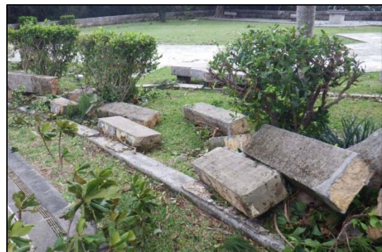
⑦石塀の倒壊
