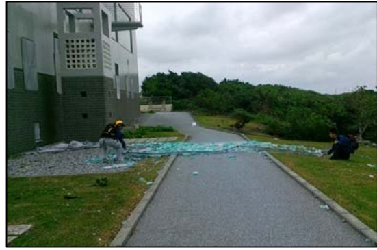
②-1 窓ガラスの破損(南から撮影)
