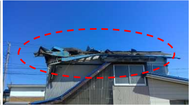
トタン屋根と屋根部材が剥離した住家 (南から撮影)
