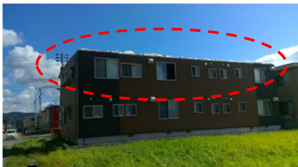
小屋組が飛散した木造アパート (北西から撮影)
