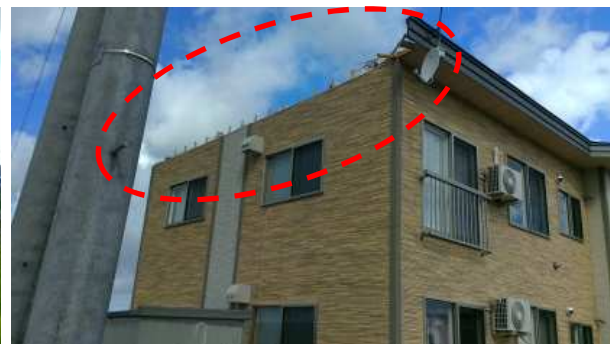
小屋組が飛散した木造アパート (南西から撮影)
