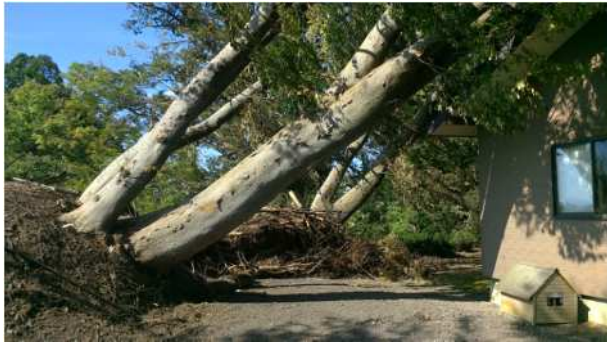
根返りした広葉樹 (南東から撮影)
