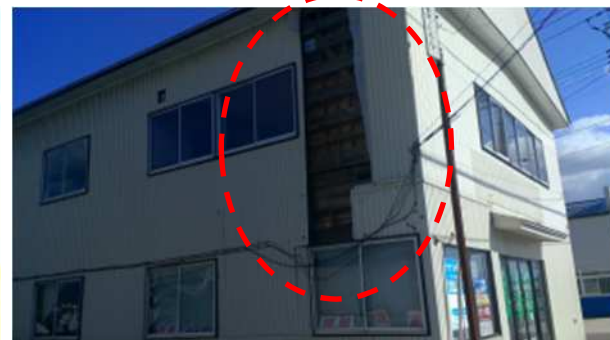
外壁が剥離した木造店舗 (北西から撮影)
