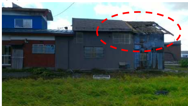
トタン屋根と屋根部材が剥離した住家 (北から撮影)
