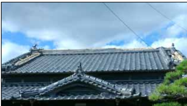
写真③屋根瓦が飛散した住家
