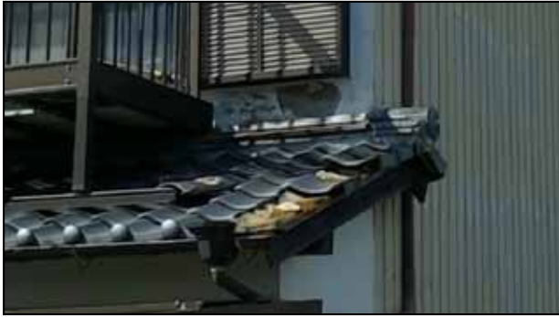
写真①屋根瓦が飛散した住家
