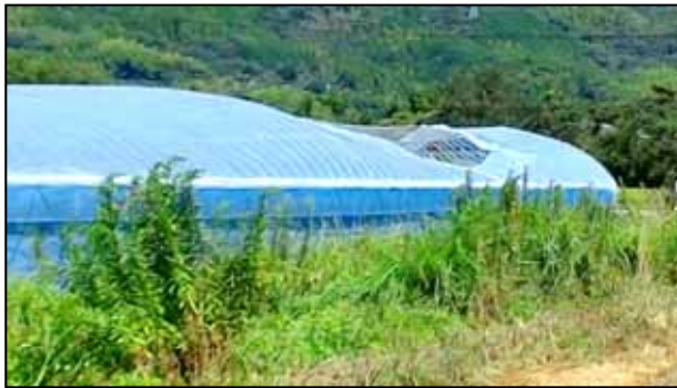
写真①鋼管が変形したパイプハウス
