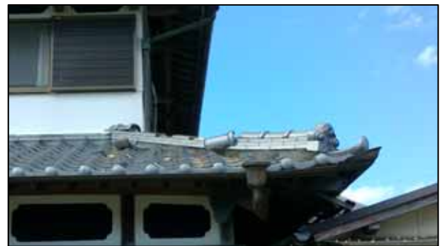
写真④屋根瓦が飛散した住家
