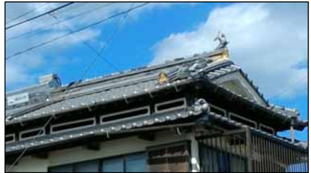
写真②屋根瓦が飛散した住家
