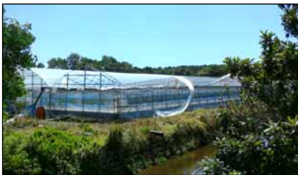
写真③鋼管が変形したパイプハウス
