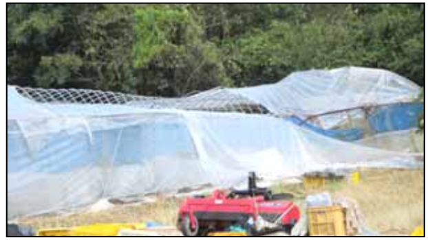
写真②鋼管が変形したパイプハウス
