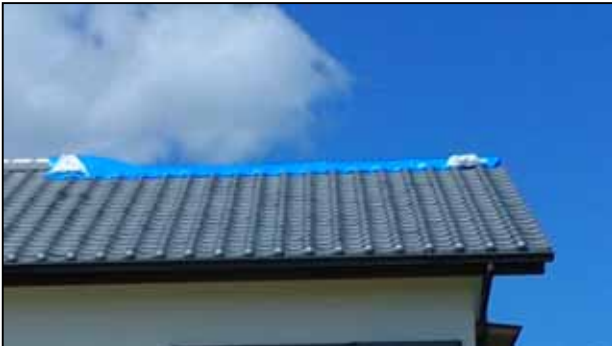
写真③屋根瓦が飛散した住家
