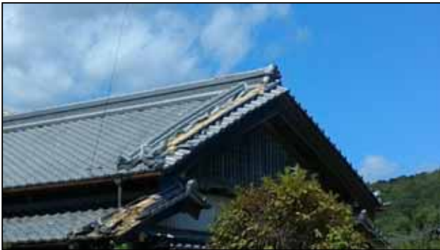
写真⑤屋根瓦が飛散した住家
