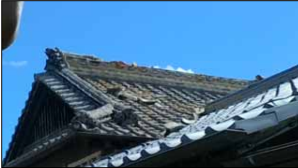
写真①屋根瓦が飛散した住家
