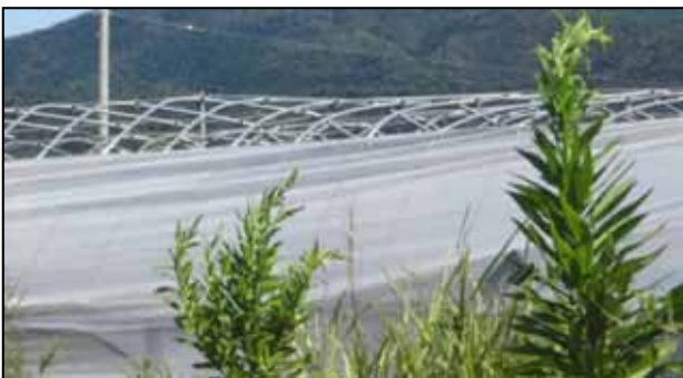
写真⑤鋼管が変形したパイプハウス
