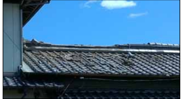
写真②屋根瓦が飛散した住家
