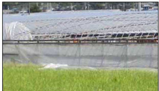
写真④鋼管が変形したパイプハウス
