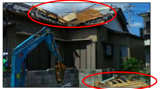
写真④ 飛散し全壊した木造倉庫の一部 (屋根上は飛散したもの。右下は周辺に飛散したものを元の位置に集めてきたもの。)
