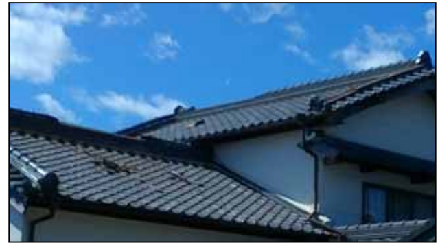
写真⑥屋根瓦が飛散した住家
