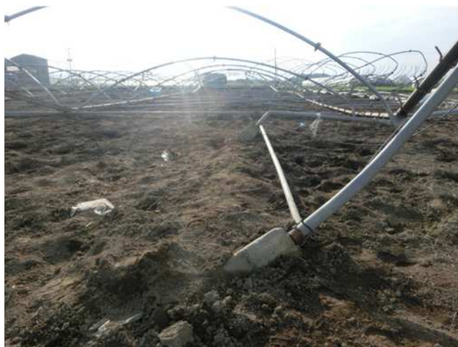
倒壊したビニールハウス(撮影方向:西)
