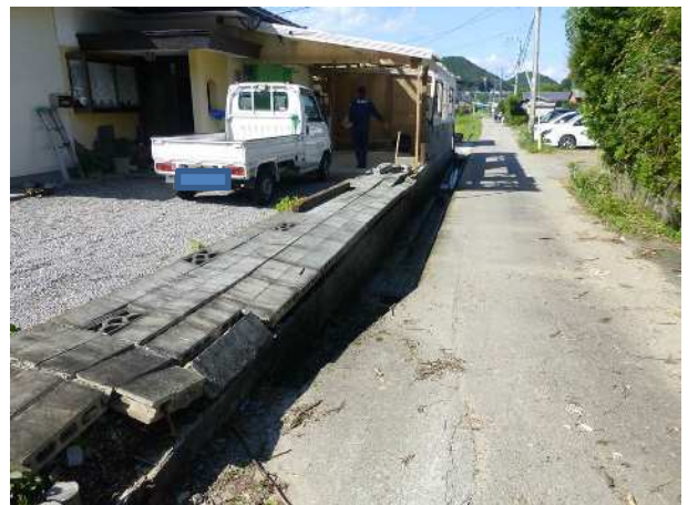
倒壊したコンクリートブロック塀(撮影方向:北)
