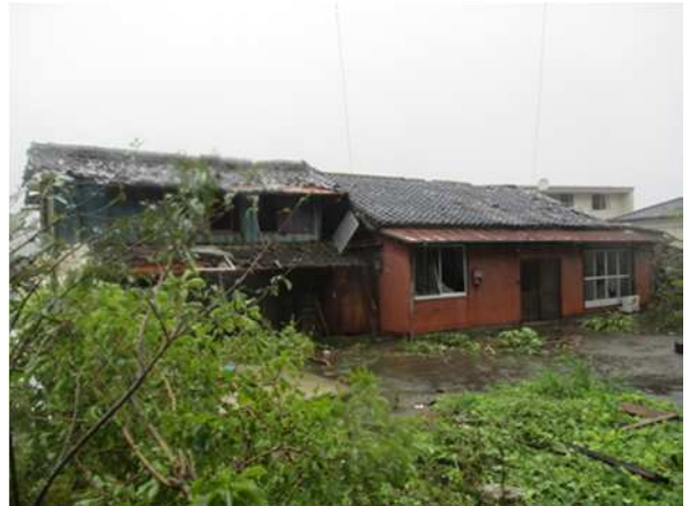
破損した非住家(撮影方向:南) 写真提供:日向市
