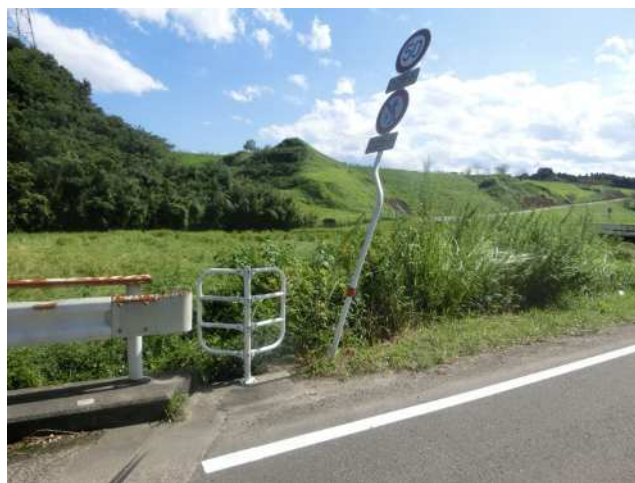
傾倒した道路標識(撮影方向:南)
