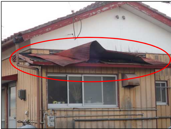
㉑トタン屋根がめくれた住家(撮影方向:南西)
