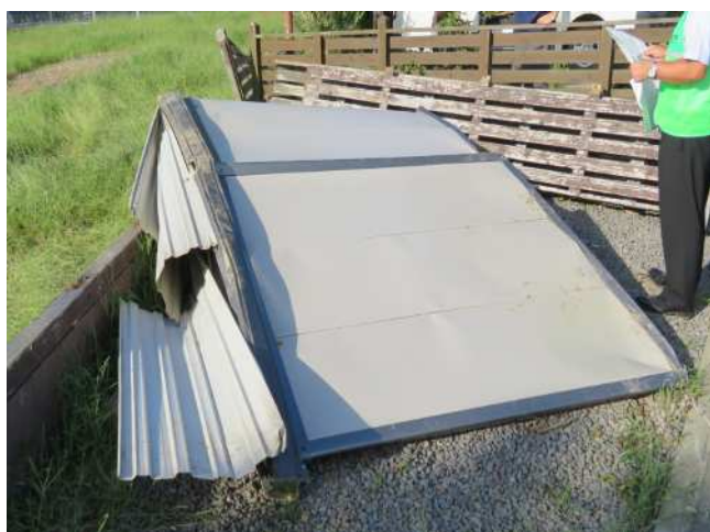
飛散し大破した物置(撮影方向:南東)
