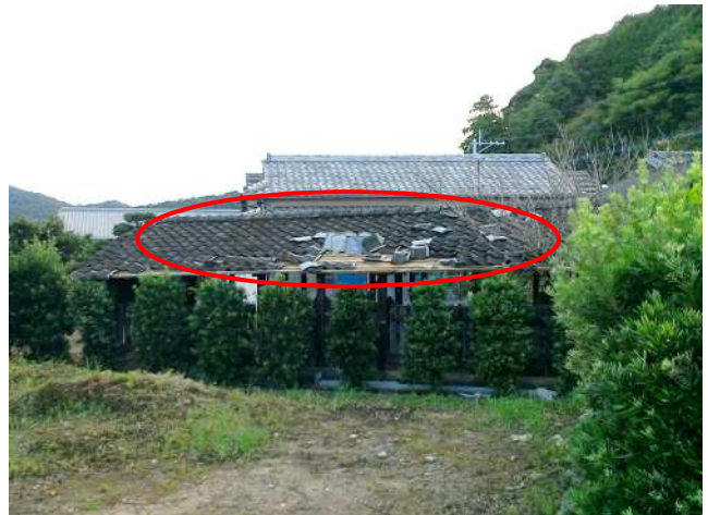
屋根瓦がめくれた非住家(撮影方向:南西)
