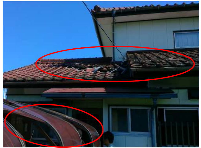
屋根瓦がめくれた住家と破損したカーポート (撮影方向:南東)
