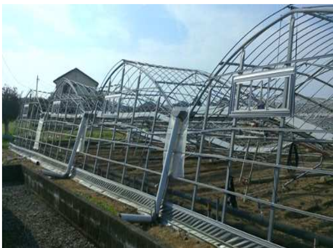
倒壊したビニールハウス(撮影方向:北西)
