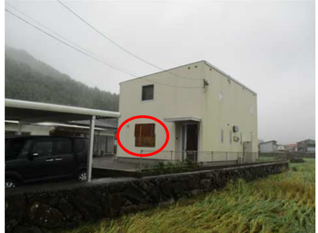
飛散物により破損した住家窓(撮影方向:西) 写真提供:日向市
