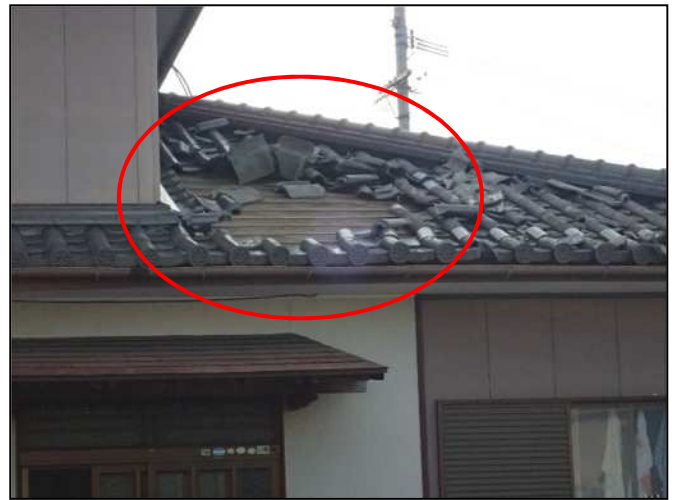
㉒屋根瓦がめくれた住家(撮影方向:西)
