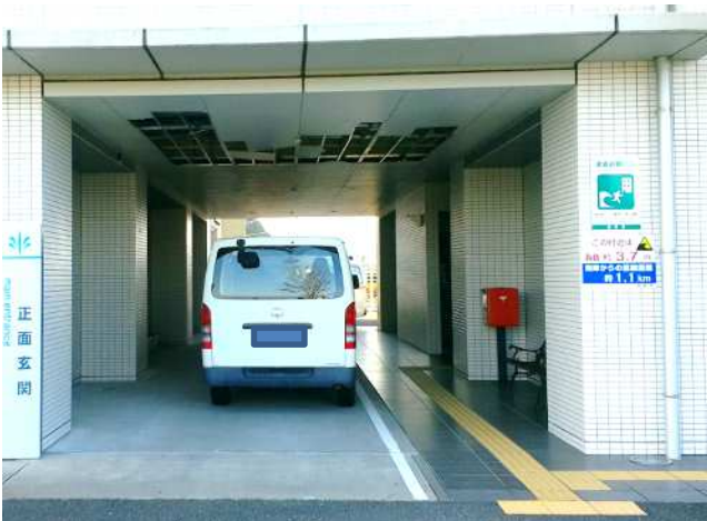
天井パネルが破損した建物(撮影方向:北)
