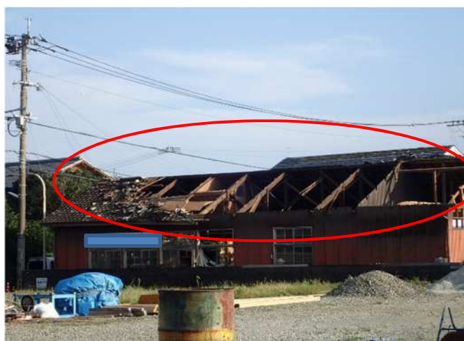
屋根が破損した作業場(撮影方向:南)
