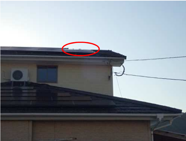
屋根瓦がめくれた住家(撮影方向:北)
