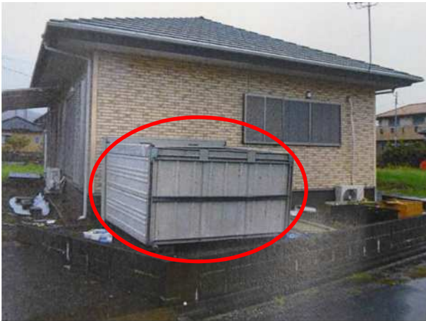
倒伏したプレハブ物置(撮影方向:西) 写真提供:日向市
