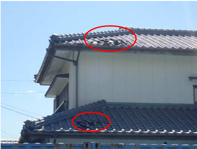
屋根瓦がめくれた住家(撮影方向:南)
