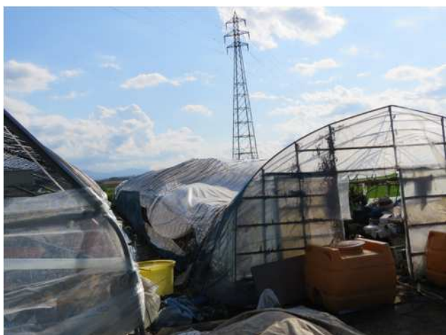
倒壊したビニールハウス(撮影方向:南西)
