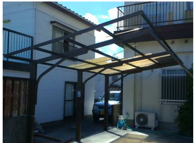
破損したカーポート(撮影方向:南西)
