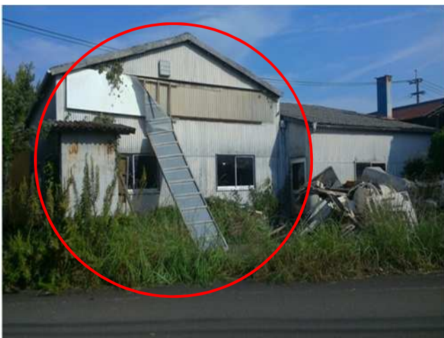
看板が剥離した倉庫(撮影方向:東)
