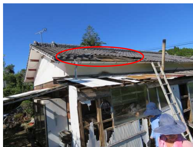
屋根瓦がめくれた住家(撮影方向:西)
