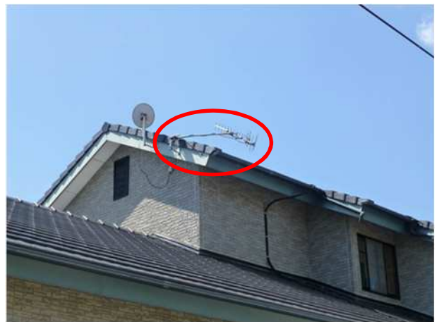
傾倒したTVアンテナ(撮影方向:南西)
