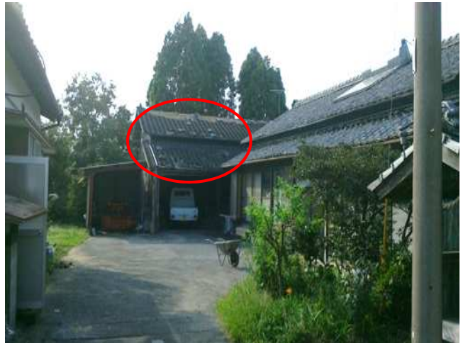
屋根瓦がめくれた住家(撮影方向:北西)
