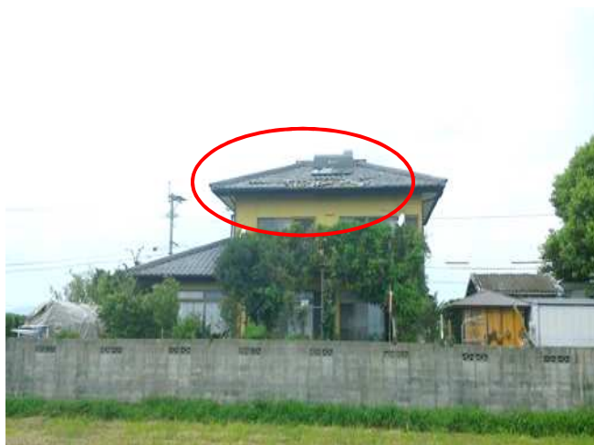
屋根瓦がめくれた住家(撮影方向:北)
