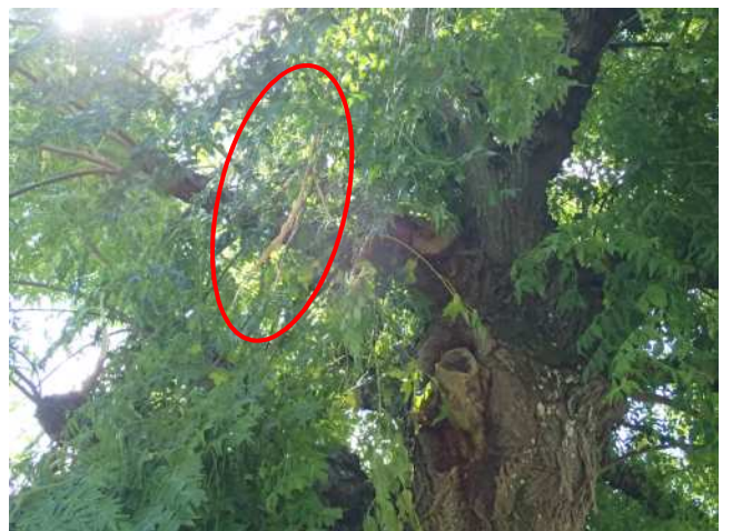
枝折れした樹木(撮影方向:北西)
