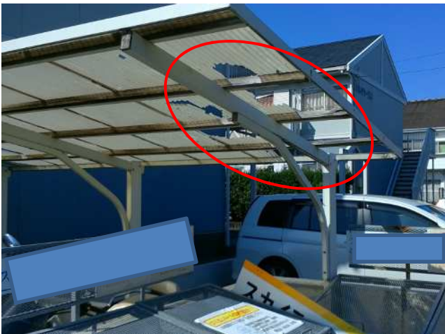
破損したカーポート(撮影方向:北)
