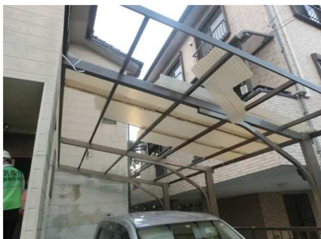
破損したカーポート(撮影方向:西)
