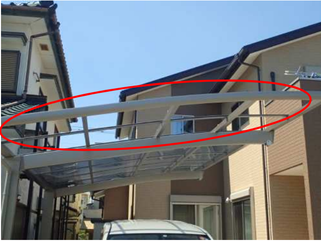
破損したカーポート(撮影方向:西)
