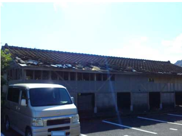
屋根瓦がめくれた非住家(撮影方向:西)
