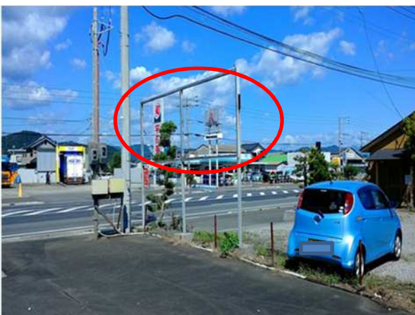
強風で剥離した広告板(撮影方向:西)
