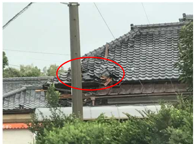
屋根瓦がめくれた住家(撮影方向:北)
