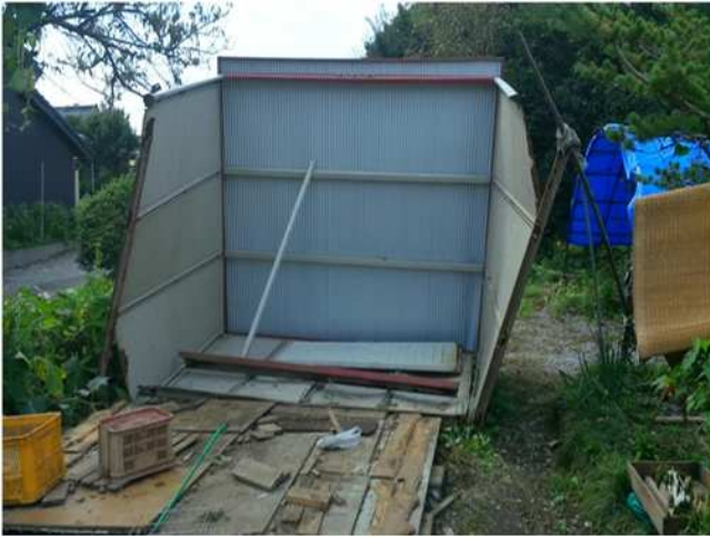
倒壊した物置(撮影方向:南東)
