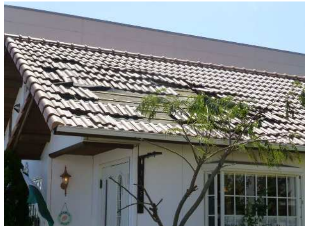
屋根瓦がめくれた住家(撮影方向:南)
