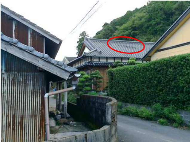
屋根瓦が浮き上がった住家(撮影方向:南西)
