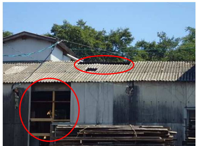
屋根と側壁が剥離した倉庫(撮影方向:東)
