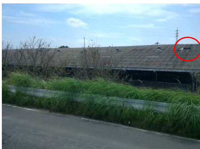
屋根が剥離した倉庫(撮影方向:南)
