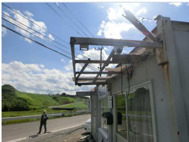
ひさしの破損した店舗(撮影方向:南)
