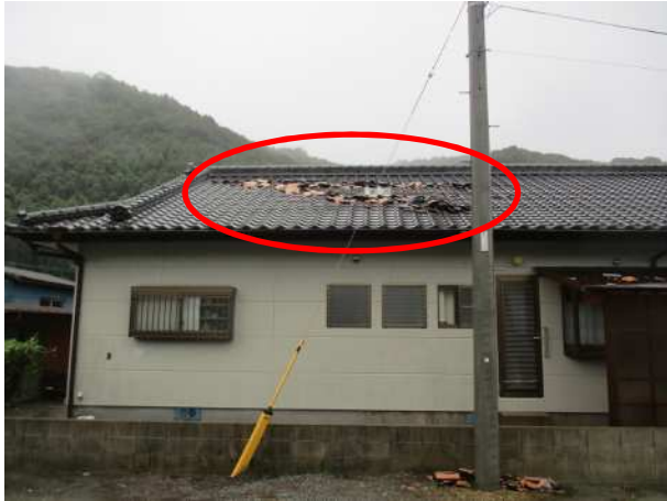
屋根瓦がめくれた住家(撮影方向:南) 写真提供:日向市
