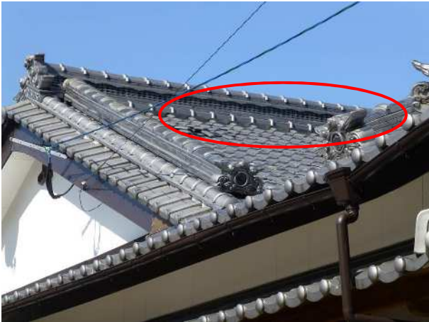
屋根瓦がめくれた住家(撮影方向:北東)
