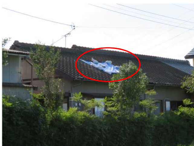
屋根瓦がめくれた住家(撮影方向:南西)
