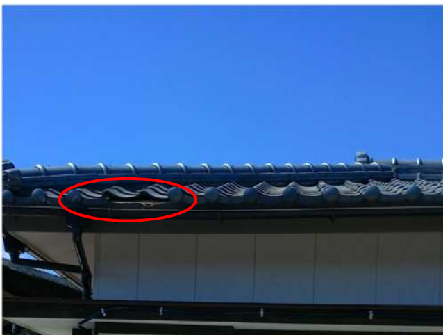
屋根瓦がめくれた住家(撮影方向:西)
