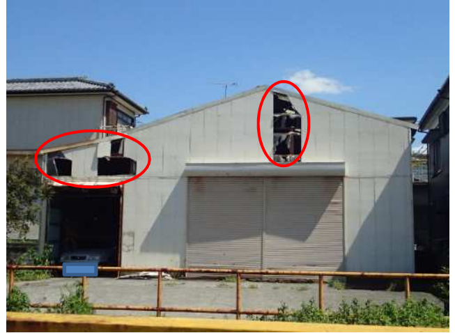
外壁が剥離した鉄骨倉庫(撮影方向:東)
