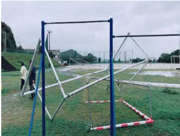
飛ばされたサッカーゴールなど(撮影方向:北) 写真提供:日向市
