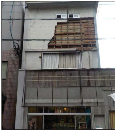
① はく離した外壁(撮影方向：南西)
