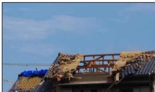
屋根が損壊した住家（北西から撮影）
