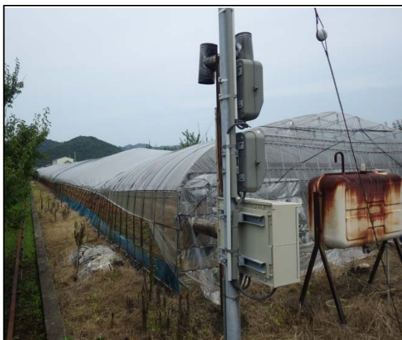
写真③ 鋼管の変形したパイプハウス
