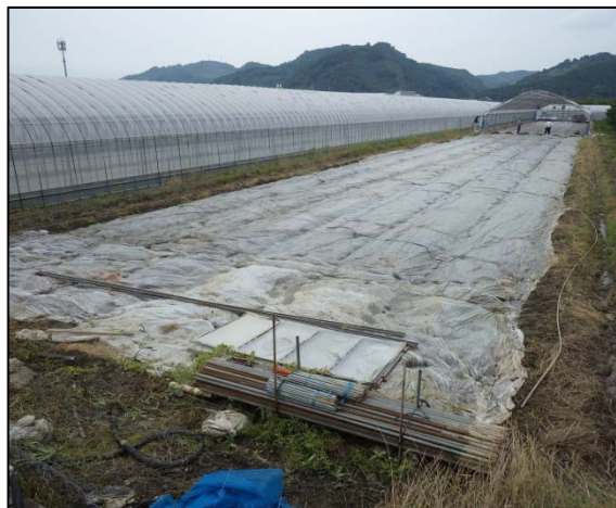
写真② 倒壊したパイプハウス（解体後の写真）
