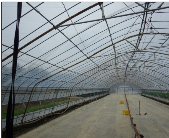
写真① 鋼管の変形したパイプハウス
