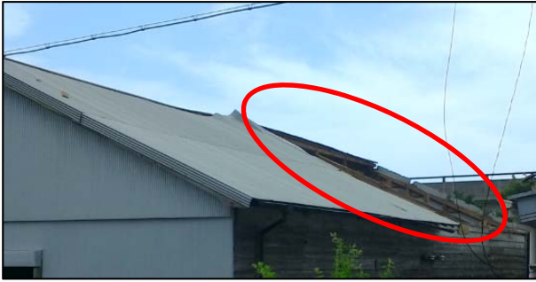
①屋根ふき材がはく離した非住家
