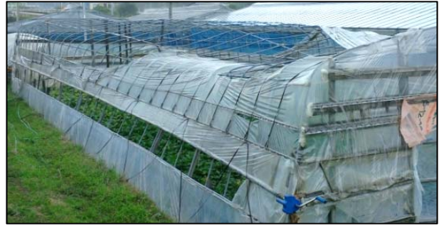
②鋼管が変形したパイプハウス
