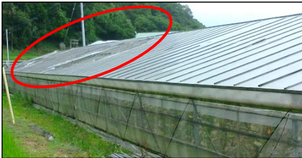
③被覆材がはく離したパイプハウス
