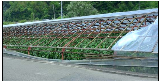
④被覆材がはく離したパイプハウス
