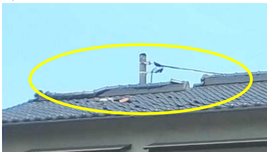
屋根瓦が飛散した住家
