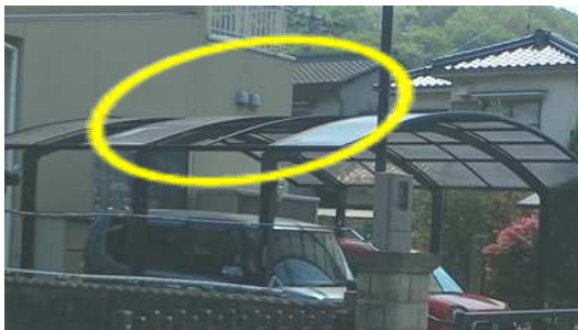
屋根が破損したカーポート
