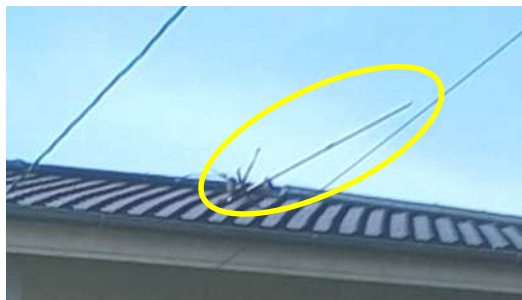
東に倒れたアンテナ
