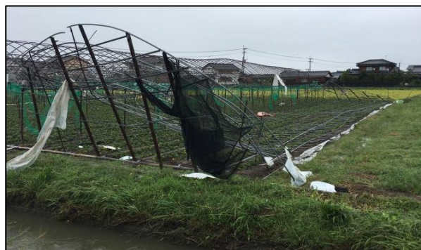
⑩倒壊したビニールハウス（撮影方向：北西）
