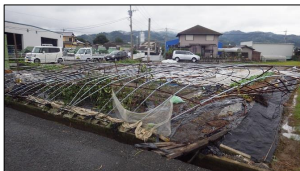
⑤倒壊したビニールハウス (撮影方向：南)
