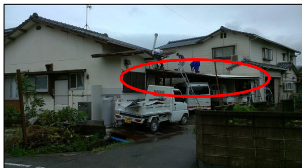
⑨トタン屋根が飛散した車庫 (修復作業中) (撮影方向: 南東)
