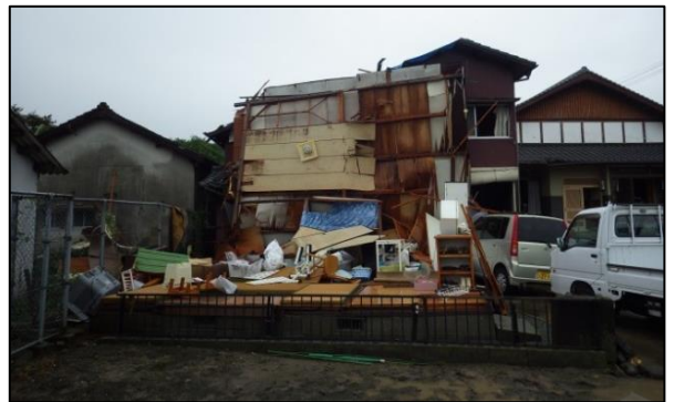
② 倒壊した住家 (撮影方向: 北)
