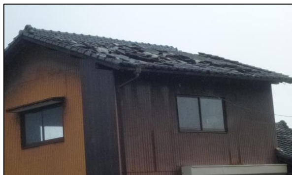
⑪屋根瓦が飛散した住家（撮影方向：南）
