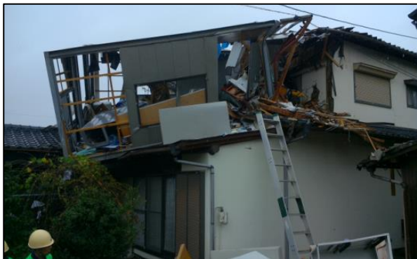
③ 住家の屋根まで飛散したプレハブ 飛散距離約80m (撮影方向: 北西)
