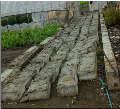
倒壊した大谷石塀 (南から撮影)
