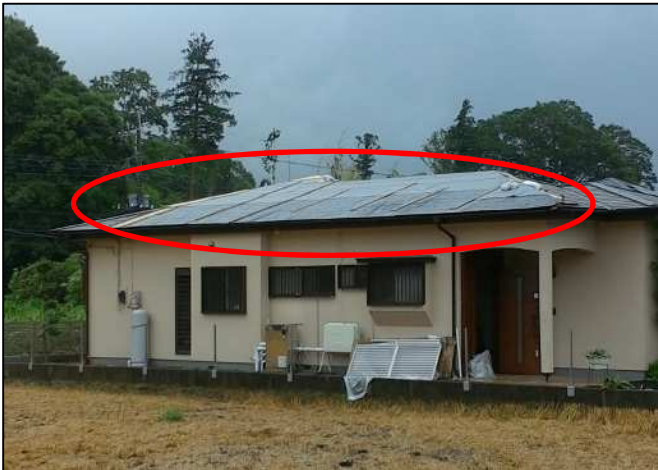
屋根が飛散した住家 (写真は修復後) (北西から撮影)
