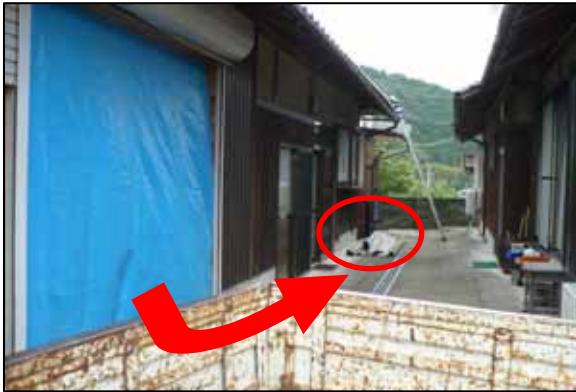
飛散したシャッター (復旧作業中)
