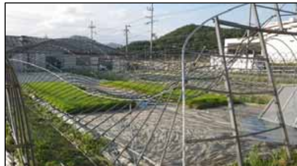
支柱が曲がったビニールハウス (ビニールは撤去済み)
