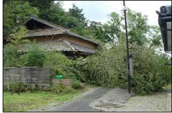
東向きに幹折れした樹木(桃) (地面から 50cm の箇所で幹折れ。太さ約 20cm)
