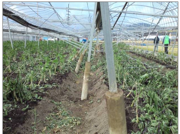
図 4 - 2 撮影場所② 支柱が土台ごと持ちあがったビニールハウス
