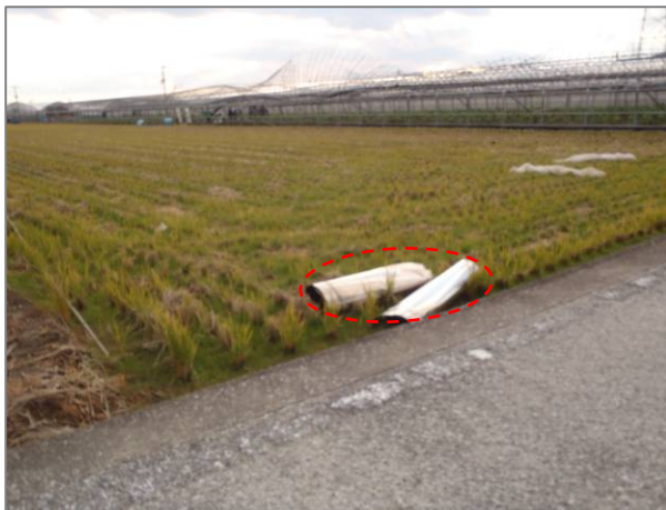
図 4 - 3 撮影場所③ 写真奥のビニールハウスから飛ばされた暖房機械の煙突
