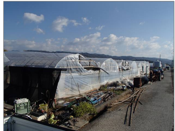
図 5 - 2 撮影場所② ビニールがめくれ、骨組みが変形したビニールハウス（写真提供：芸西村役場）
