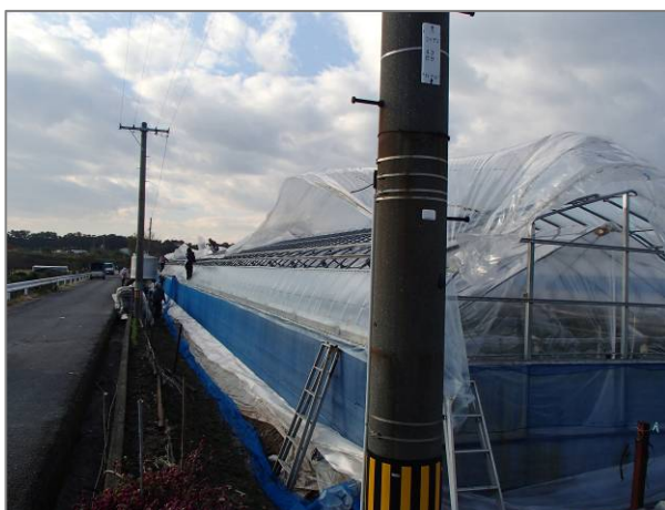
図 5 - 3 撮影場所③ ビニールがめくれたビニールハウス （写真提供：芸西村役場）
