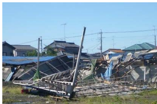
④ 倒壊した資材倉庫 (埼玉県行田市下池守)
