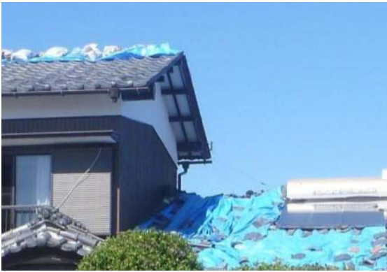
③ 屋根瓦が飛散した住家 (修復作業中) (埼玉県行田市南河原)
