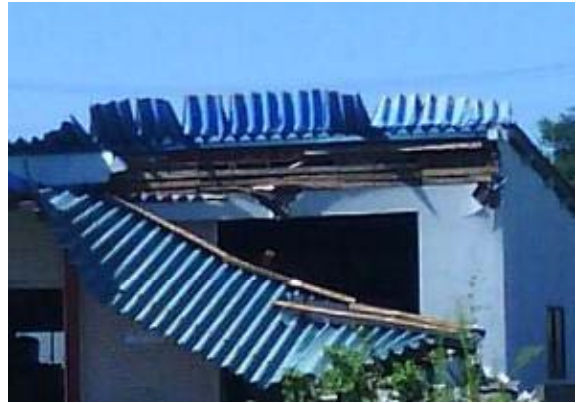
② トタン屋根の一部が損壊した車庫 (埼玉県行田市中江袋)
