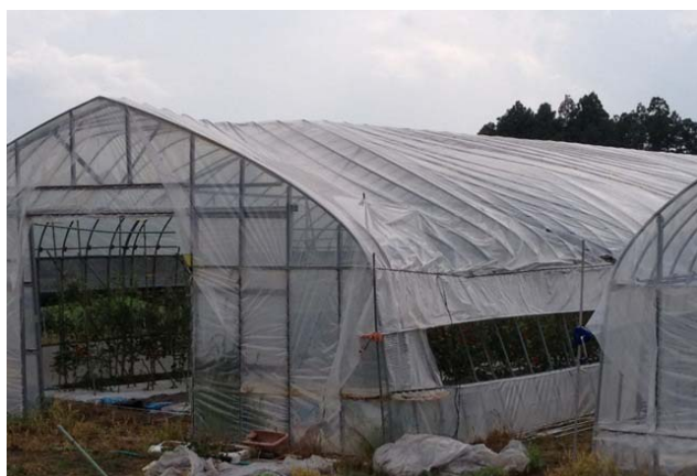
③一部損壊したビニールハウス (北東から撮影)
