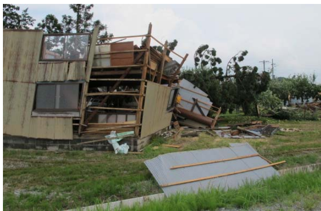
①全壊し南東に倒れた作業小屋 (北西から撮影)
