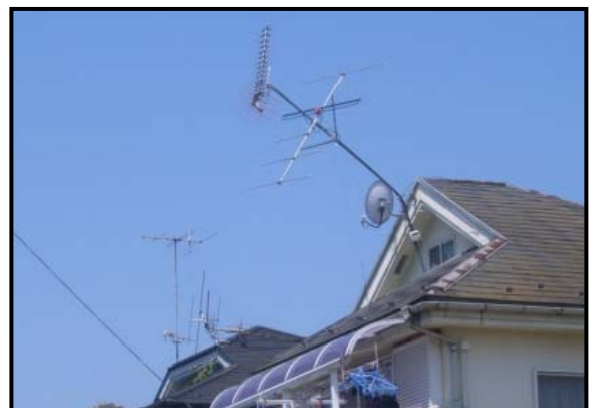
⑥ 倒れたアンテナ （群馬県邑楽郡邑楽町：南東から撮影）
