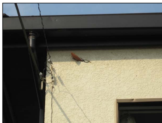
⑦飛散して突き刺さった瓦
