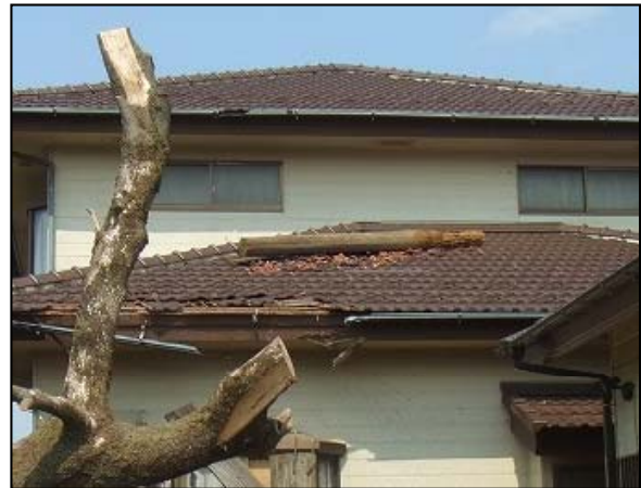
③住家一階の屋根に飛ばされた丸太
