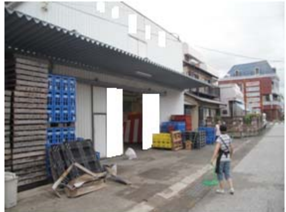
図 4-10 撮影場所⑩ 建物の前に積み上げていた瓶が南側に倒れた（写真は、片付けられたあと）。
