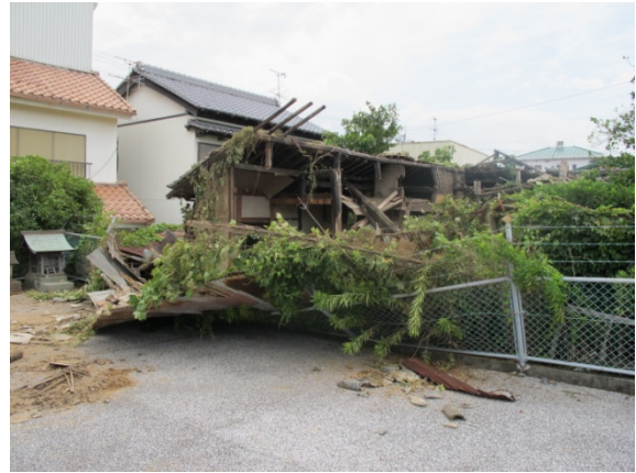
図 4-8 撮影場所⑧ 住家（空家）が西方向に倒壊し、飛散している。
