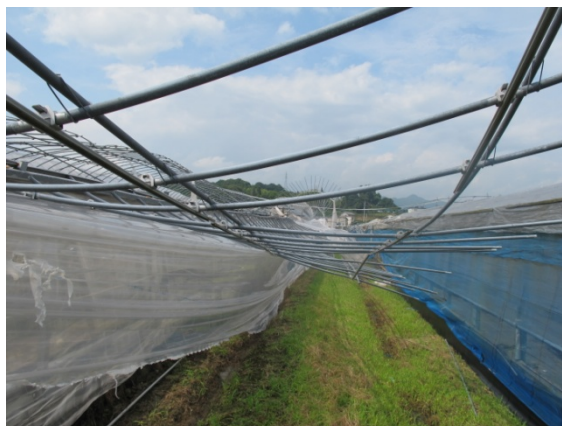
図 4-2 撮影場所② ビニールハウスのビニールが捲れ、支柱が大きく変形している。
