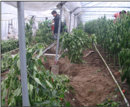
ビニールハウス内の支柱が浮き上っている (西側から撮影)
