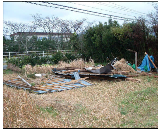
物置小屋の倒壊跡(東側から撮影)
