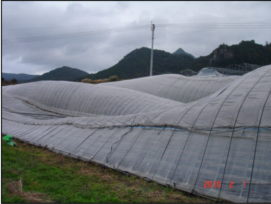
南東側に倒れたビニールハウス (西側から撮影)
