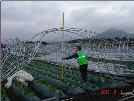
倒壊したビニールハウス (南東側から撮影) (ビニール飛散方向:東)
