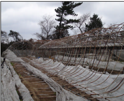
ビニールハウスの損壊(南側から撮影)
