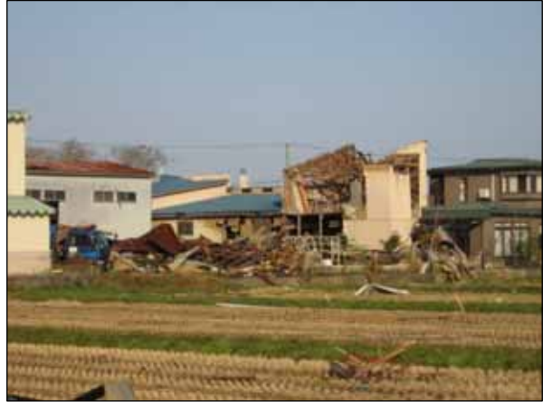
全壊し、東方向へ飛散した倉庫 (南東から撮影)
