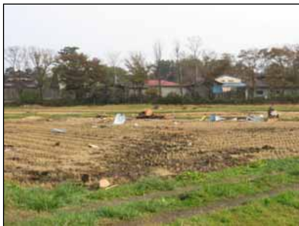
全壊し、南方向に飛散した物置小屋 (北西から撮影)
