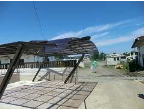
支柱の折れ曲がったカーポート
