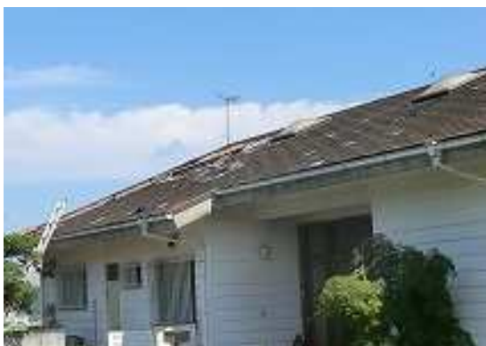
スレート屋根瓦がめくれた住家
