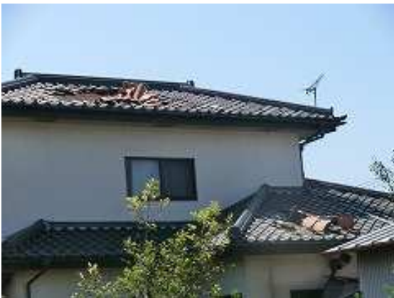
屋根瓦が飛散した住家
