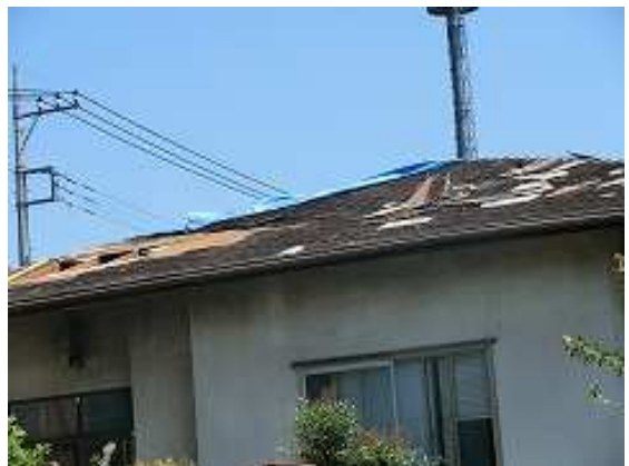
スレート屋根瓦がめくれた住家
