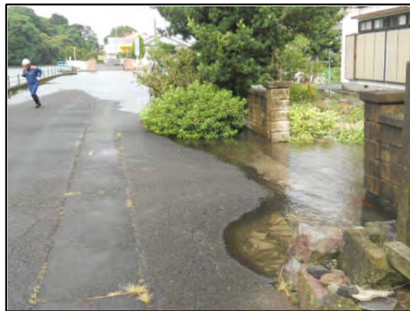
②神代川沿い道路冠水（雲仙市国見町）
