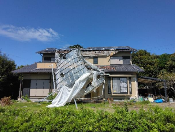
③飛散物により破損した住家 (南方向から撮影)
