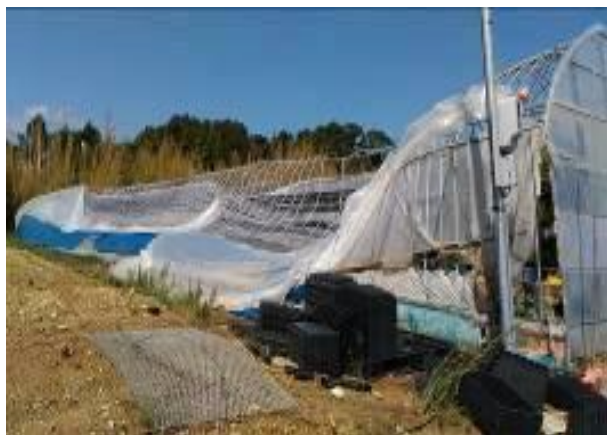
全壊したビニールハウス（イチゴ）
