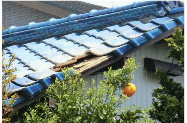
② 屋根瓦が落下した住家
