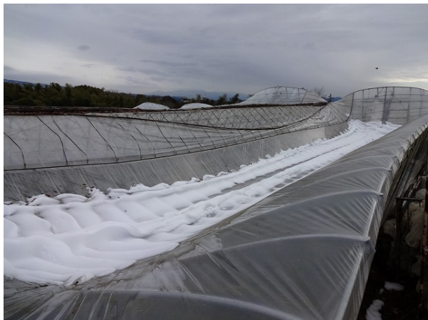
①倒壊したビニールハウス(野菜)
