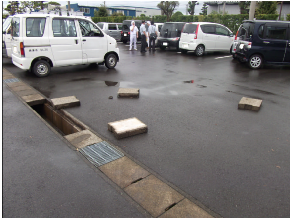
③ 側溝の蓋が飛散
