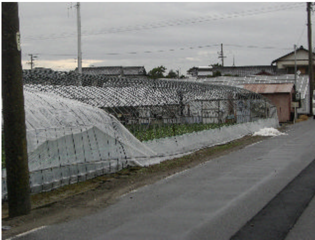
⑤ ビニールがめくれ上がったビニールハウス
