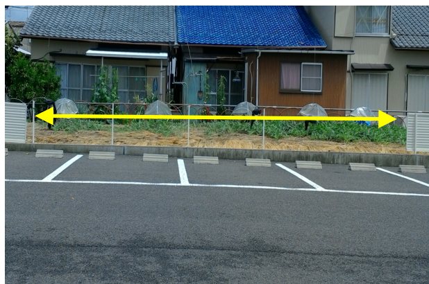
② 一部が倒壊した工場のフェンス (南方向から撮影)
