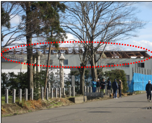
③剥離した屋根 (北西から撮影)
