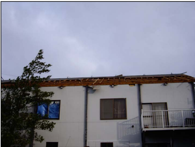
③剥離した屋根 (南から撮影)
