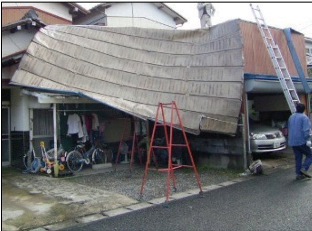
① はがれ落ちたトタン屋根 (北西から撮影)
