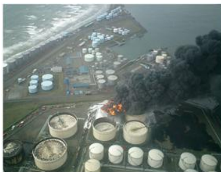
写真 1 石油タンクでスロッシングが発生 （総務省消防研究センター提供）
