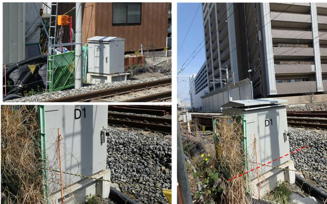
地点⑥：線路冠水（赤点線が浸水痕を示す）
