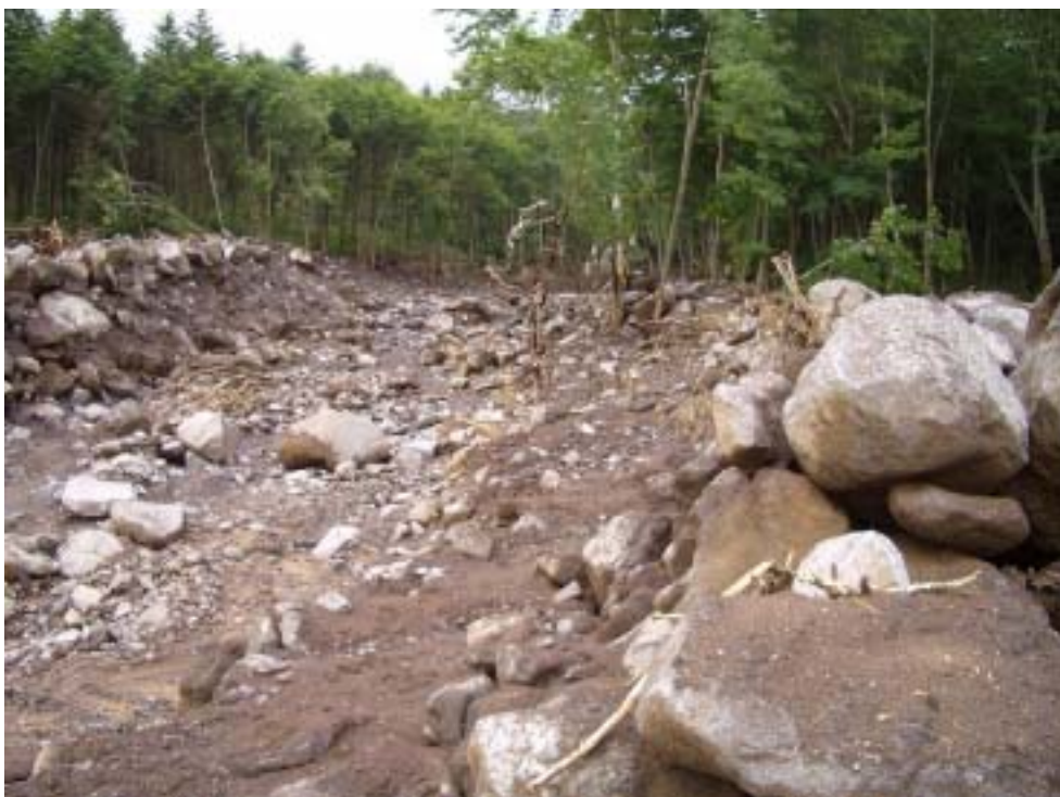
砂防ダム上流側の流出状況
