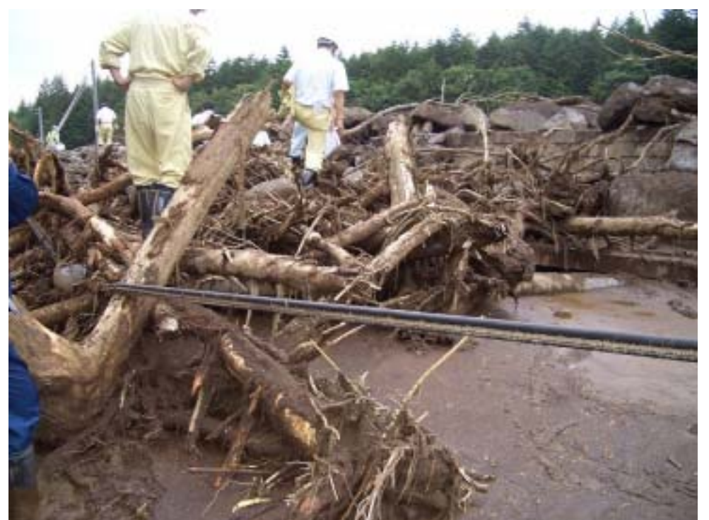
県道網張温泉線に流出した枯木により倒れた電柱
