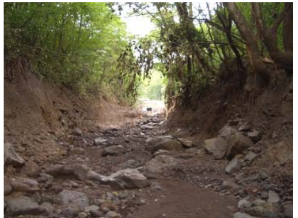
砂防ダム下流側の流出状況 中央に見えるのは砂防ダム排水口
