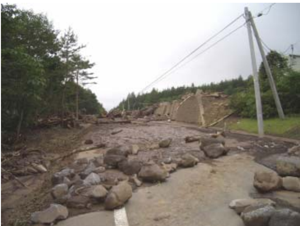
駐車場付近の県道網張温泉線の状況
