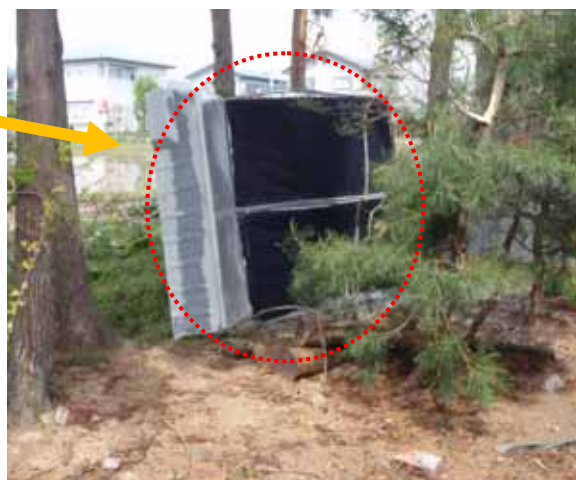
写真7 C：落下したソーラー温水器 (北側に落下し樹木に接触した模様)
