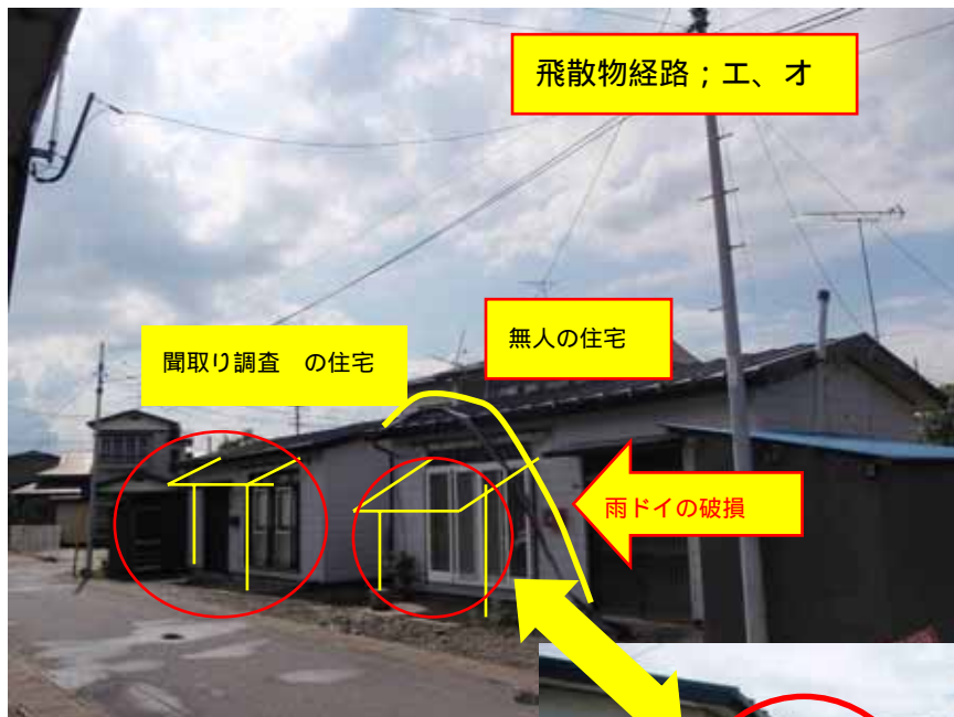
写真 K 被災した住宅 聞き取り調査の隣家は無人 ひさし及び雨ドイ破損
