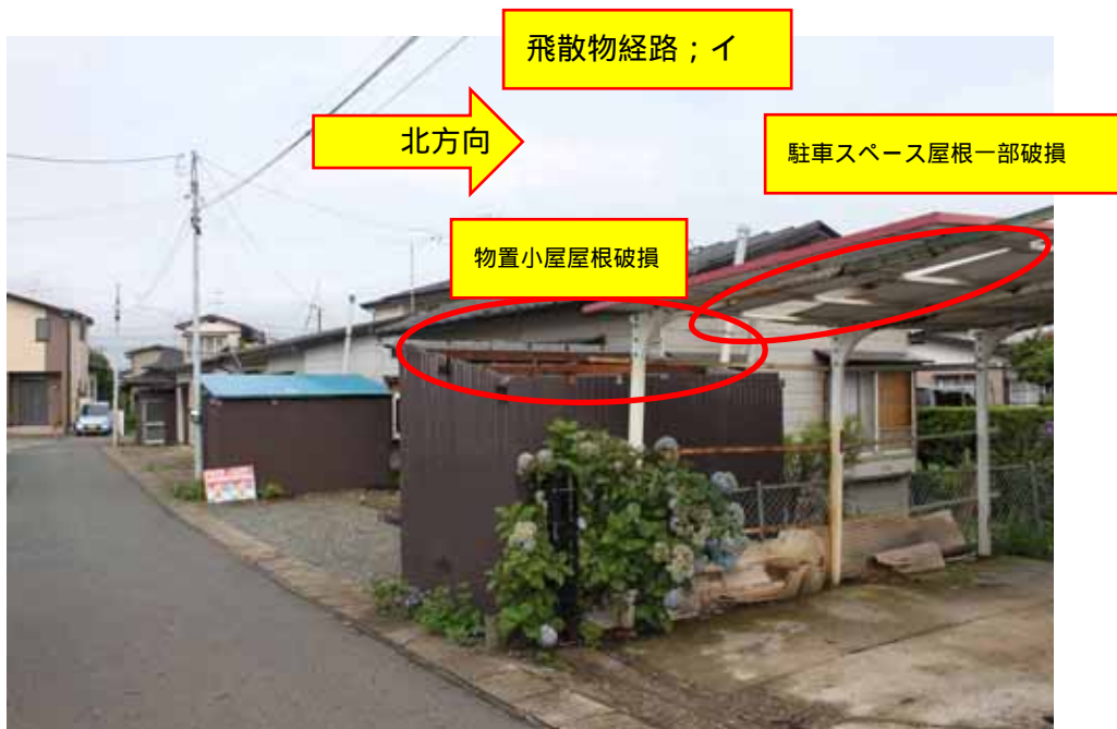
写真 J 被害が多かった地域の通りを東から西方向に撮影（写真提供；盛岡西消防署） 物置小屋の屋根が飛ばされ、写真 E の位置でフェンスに引っかかる。この住宅では、 ひさしが、写真 F 又は写真 G へ飛散したと思われる。また、聞き取り調査 の住宅の駐 車スペース屋根一部破損。
