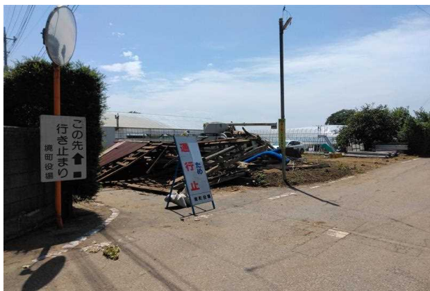
⑬ 非住家の倒壊 (東方向から撮影)
