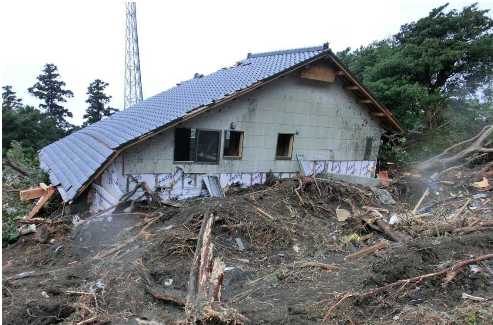
平成25年台風第26号による土砂災害 東京都大島町
