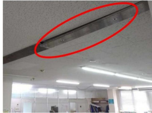
写真2 天井の金属製パネルの剥離
