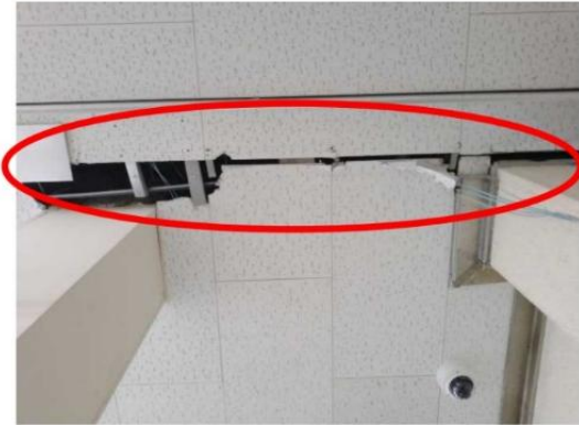
写真1 天井石膏ボードの損傷
