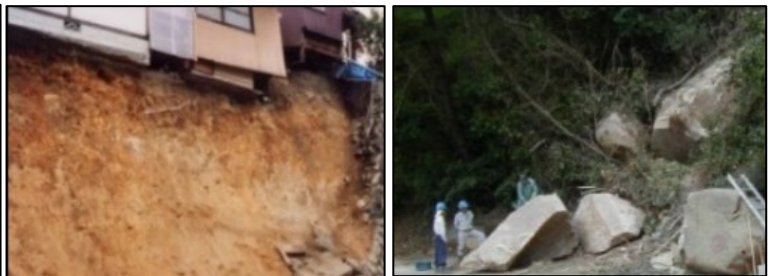
被害写真（気象庁現地調査資料より） 左：石垣の崩れ、右：落石
