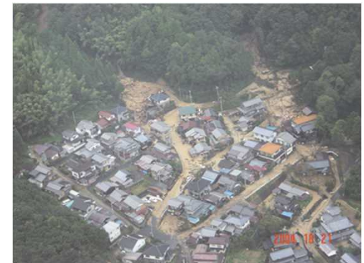
京都府宮津市の土石流の状況 「平成16年台風第23号災害の記録」 （平成17年10月 京都府）
