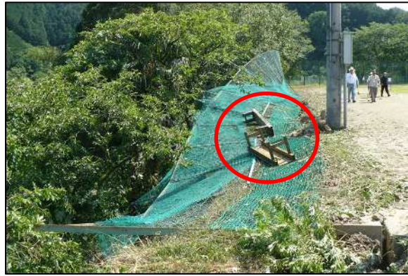
東向きに飛ばされた木製ベンチと倒れた グランドフェンス
