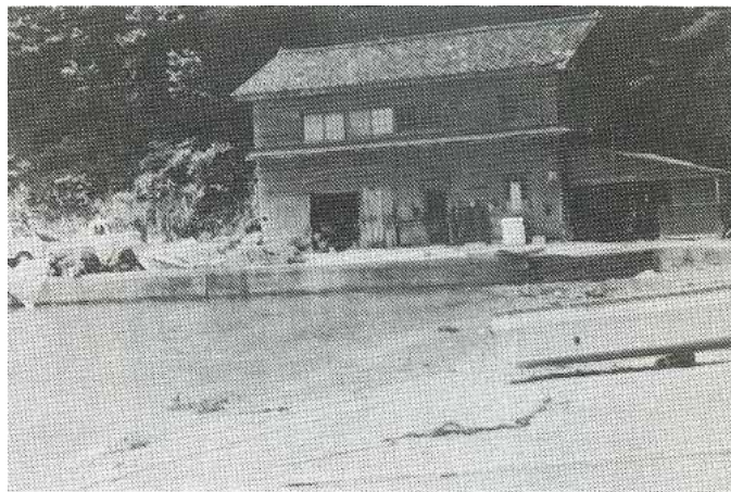
写真 日本海中部地震による津波被害の様子 （舞鶴市野原港。5 月 27 日 12 時 15 分。舞鶴海洋气象台。 倉庫入口の半分の高さまで浸水の跡がある（暗色部） 気象庁技術報告 第 106 号（1984 年）より
